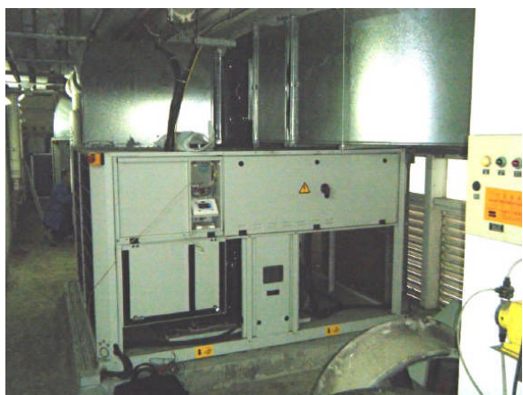
該名員工在水泵機組進行更換工作
