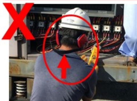
圖1: 工人在配戴安全帽時，不能同時正確使用過頭式耳罩
