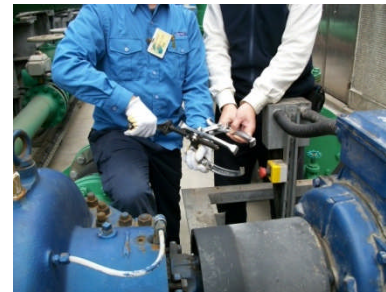
技工使用工具拆卸設備組件
