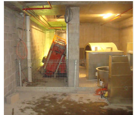
高架升降台墜落的位置
