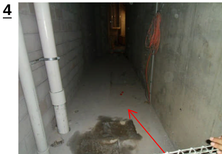
上述工作位置的地板上，類似的洞穴覆蓋層。混凝土與周圍的灰塵偽裝成普通地面
