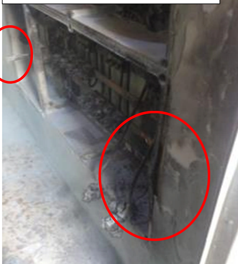
正在進行電力接駁的位置
