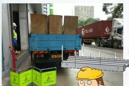
員工進行吊運工作時，未有完全圍封吊運區域。
