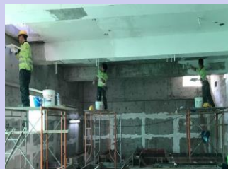
工人正在使用不合規格的工作平台以及未有佩帶安全帽及安全帽繩。發現後即時停止工作並提供安全訓練及較剪式動力工作平台予工人使用。
