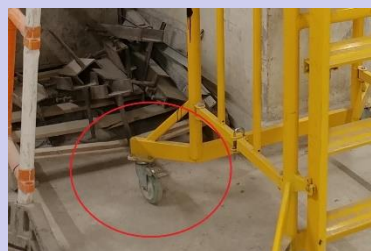
工友使用流動工作台時，未有鎖上所有腳輪輪鎖。現提醒員工在使用流動工作台前，必須檢查並確保所有腳輪輪鎖已鎖上。
