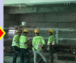
工人正在使用不合規格的工作平台以及未有佩帶安全帽及安全帽繩。發現後即時停止工作並提供安全訓練及較剪式動力工作平台予工人使用。
