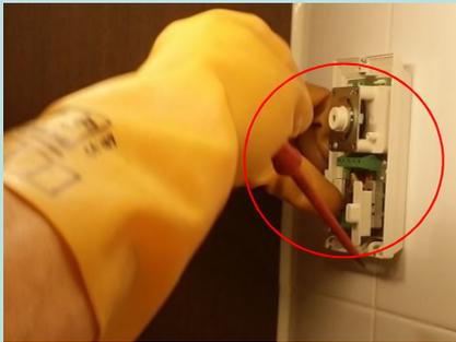
審核中發現員工完成上鎖掛牌隔離電源後進行維修工作時及員工搬運梯台時，**沒有除下絕緣防電手套**，此舉有機會對防電手套損壞，若員工未有及時發現，隨即進行帶電工作，便會對員工構成觸電的潛在危險。
