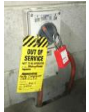
圖一：整個系統進行上鎖掛牌
