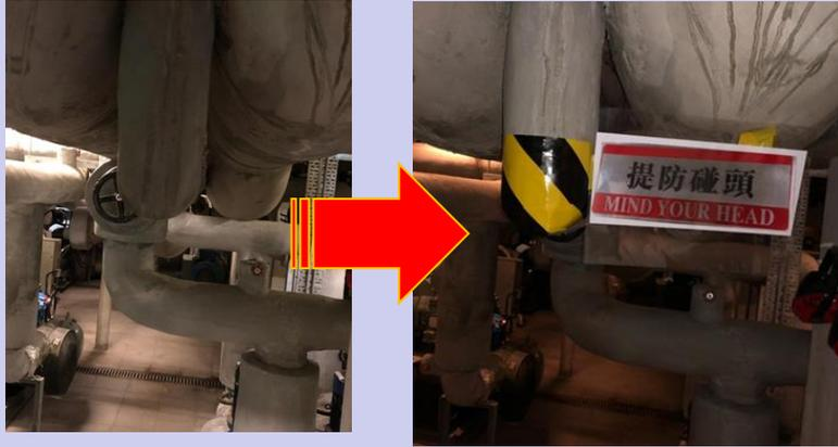
當員工進行保養工序時，發現水喉位置凸出，容易對員工構成碰頭之危險。匯報上司得到主管批准，於水喉位置加上軟墊及貼上警告標示，以提醒在場人仕對碰頭位置提高警覺性及減輕員工撞頭受傷之嚴重性。
