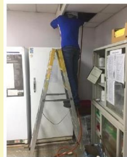
圖一及圖二:員工在A字梯上處理風機盤管漏水問題
