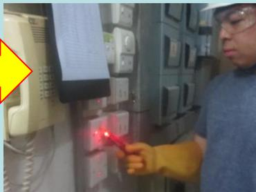
在安全審核中發現技工在測試接地測試筆時，沒有配戴絕緣手套，現提醒所有員工在測試接地測試筆和電壓錶，以及進行上鎖掛牌、測試程序時都必須配戴絕緣手套來以防觸電。另再次提醒員工，使用接地測試筆對設備外殼進行測試時，接地測試筆的筆尖必需與設備外殼直接接觸，以避免測試結果出現人為的誤差。
