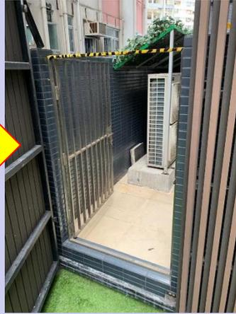
當員工進行保養工序時，發現天台進入散熱機組範圍的閘門頂部有碰頭的危險，容易對員工構成撞傷頭部之危險。向客戶匯報有關危險情況後，客戶同意讓我們於閘門框的頂部貼上警告標示，以提昇在場人仕對閘門框架位置的警覺，減少在場人仕因門框頂頭而撞倒構成受傷的危險。
