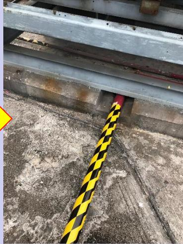
當員工進行保養工序時，發現天台的水管，容易對員工構成絆倒之危險。向客戶匯報有關危險情況後，客戶同意讓我們於水管貼上警告標示，以提昇在場人仕對水管位置的警覺，減少在場人仕因水管絆腳而構成受傷的危險。
